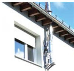
inoxydable. Les éléments de base sont deux tôles triangulaires qui créent la base et sont fixées au mur extérieur. Cette console autorise des distances de 50 à 100mm.
